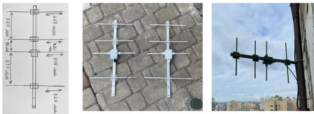
Рис.3. Виготовлення і встановлення антен радіомосту.
