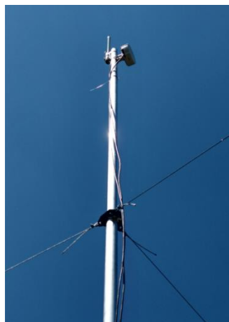
Мачта із прийомопередавачем «точка-точка» та «точка-багатоточка».
